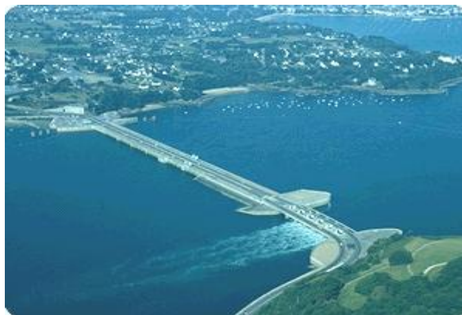
Obr. 11 – Prílivová elektráreň 240 MW na rieke La Rance vo Francúzsku.
